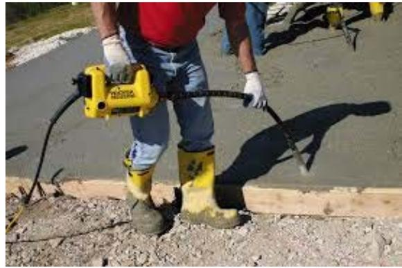
Figura 6: Vibrador Interno
