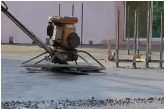
Figura 7: Flotador vibrante
