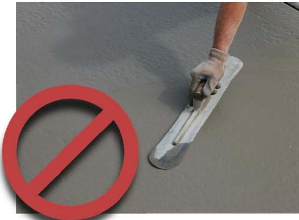
Figure 14: Nivelador de acero
