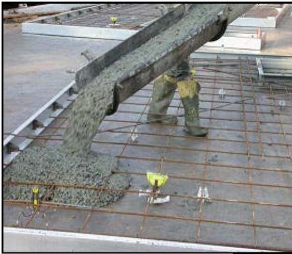
Figura 1: Concreto dentro del rango de revenimiento siendo colocado cerca a su destino final.
